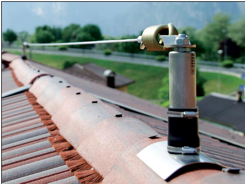
Pali in acciaio posti sul colmo della copertura
